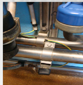
Liaison équipotentielle du lactoduc (impératif)
