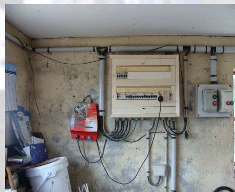
Type d'installation fortement déconseillé (clôture)
